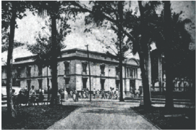
Edificio de la antigua Universidad de El Salvador, una de las primeras sedes del Museo Nacional
