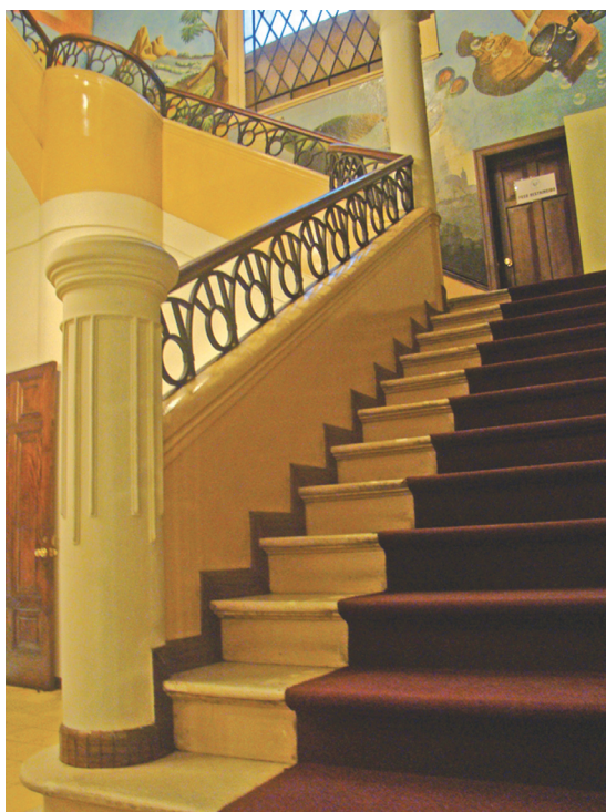
Detalle arquitectónico del MUA
