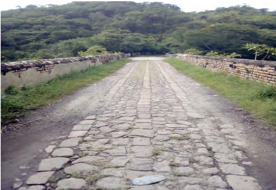
*Detalle de la calzada del puente. Claramente se ve la falta de mantenimiento. La ineffectividad de los desagües por falta de mantenimiento retiene las aguas pluviales y la humedad en la calzada. Es evidente que a largo término minará la estructura del puente. Foto: Eduardo Rivas.*
